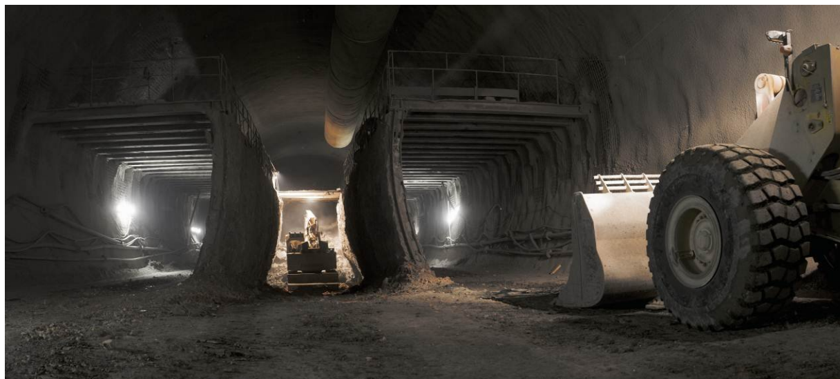
Obr.1. Pohled na stavební práce v tunelové trouby II v úseku před demontáží dočasné výztuže primární obezdívky dílčích výrubů.
