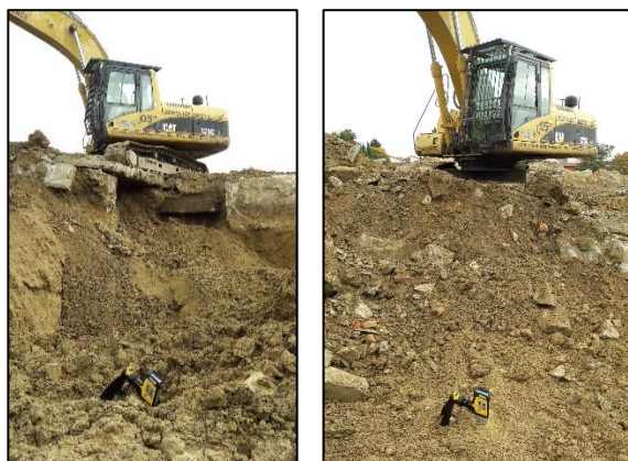
Obr. 6: Odtěžba kontaminované zeminy kontrolovaná pomocí ED-XRF spektrometru DELTA
